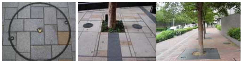
▲권장 : 보도와 동일한 높이면을 지닌 맨홀 및 가로수 보호덮개
