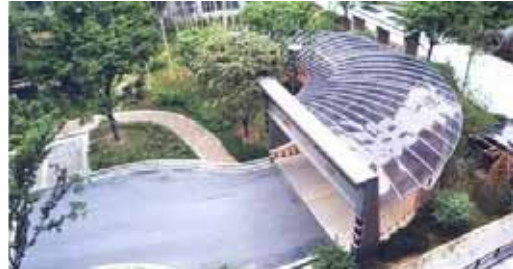
▲권장 : 자연채광을 이용한 지하주차장 진출입구
